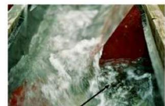
Le déflecteur à 30° fait office de barrage. Le niveau d'eau rehaussé au-dessus de ce « barrage » permet aux poissons de se reposer, à l'abri du déflecteur à 60° en amont.
