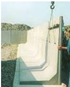
En cas de réglage nécessaire sur une semelle irrégulière, il y a lieu d'étendre une couche de sable stabilisé ou de mortier.
